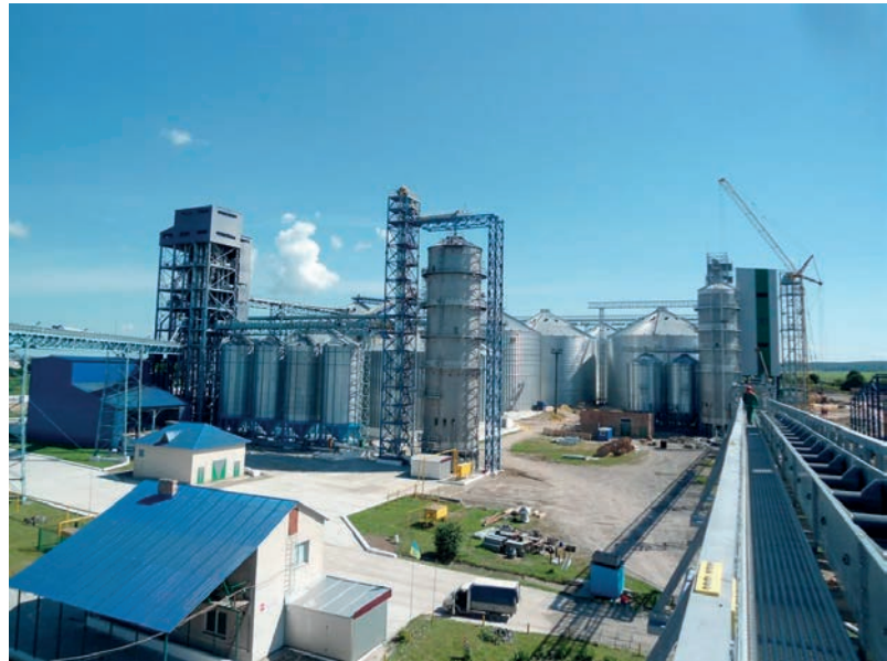
Будівництво зерносховища ємністю 50 тис. т з вузлом перевантаження зернових на залізничний та автотранспорт (Україна, м. Дубно, Рівненська обл.)
